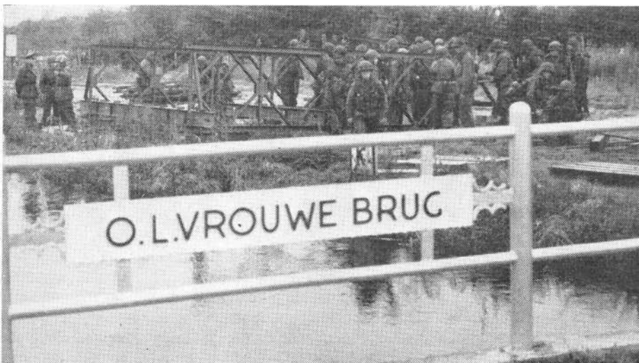
Naast de bestaande brug bij Waalre over de Dommel, bouwde de C-cie 41Geniebat een baileybrug op de door de hoge waterstand drassig geworden oevers
