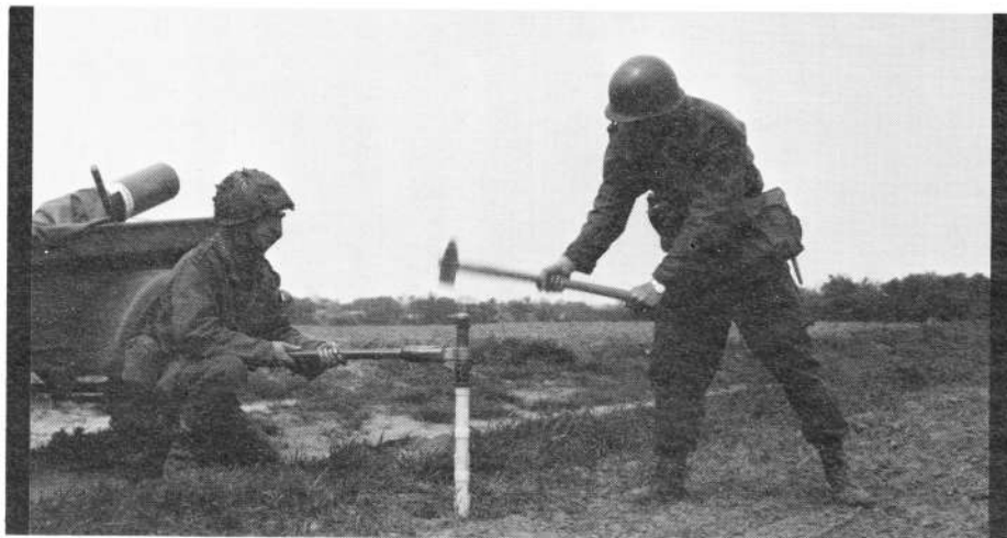
Het punt is gemeten... Kanonnier I W. S. van der Heijde mept een piket de grond in. Eerste-luitenant J. T. Zweytzer zorgt ervoor dat dit loodrecht gebeurt...
